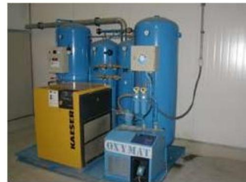
Иллюстрация 5.2 Генератор кислорода. Необходим контроль и уход за специальным оборудованием.
