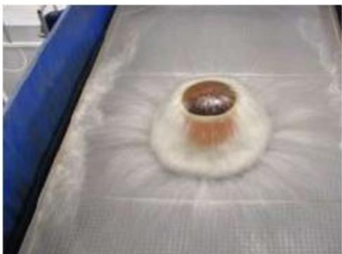
Иллюстрация 5.1 Качество и течение воды в фильтрах и рыбоводных бассейнах должны часто контролироваться визуальным способом. На фотографии изображена верхняя поверхность традиционного капельного фильтра, откуда вода стекает вниз по заполнителю фильтра.
